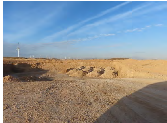
Depósito de tierras procedentes de la obra en zona de préstamo.
