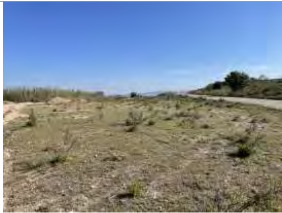
Zanja de la LAAT hacia aerogeneradores
