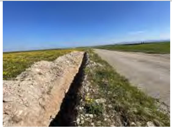
Zanja abierta para el regadío. Mismo trazado que la LAAT
