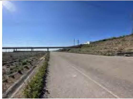
Inicio de la zanja desde la Subestación
