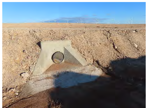
ODT concluida con plataforma de disipación de energía a la salida.
