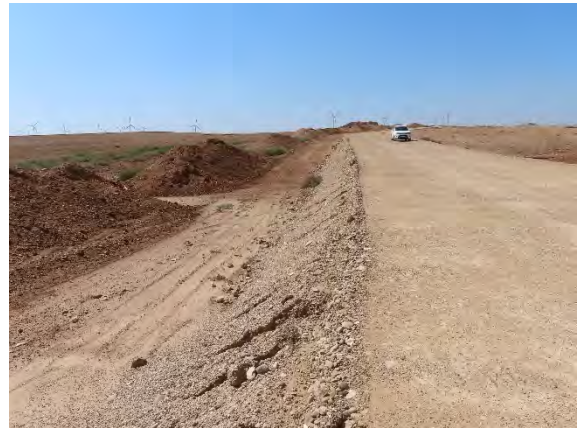
Canal de paso para el drenaje superficial habilitado en el cordón de tierras.
