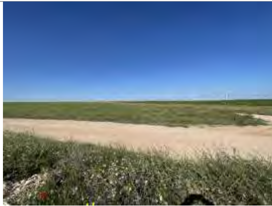
Zanja de la LAAT hacia aerogeneradores
