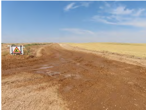
Viales de acceso al parque recientemente regados para evitar levantamiento de polvo.
