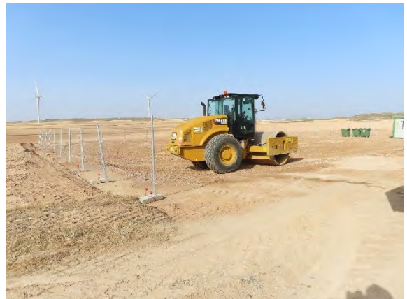
Compactación del suelo en área auxiliar.
