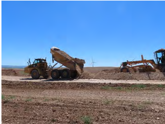
Compensación de tierras. Relleno en viales con tierras de excavación de las cimentaciones.
