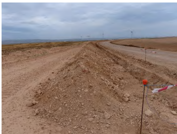
Zanja eléctrica abierta, respetando lo acopios de suelo fértil previos.
