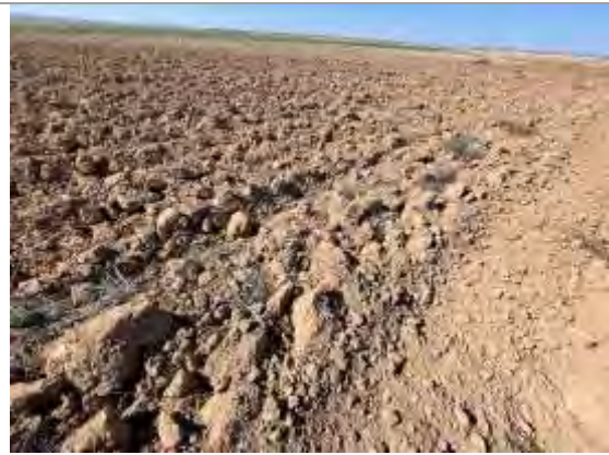
Zanja de la LAAT hacia aerogeneradores
