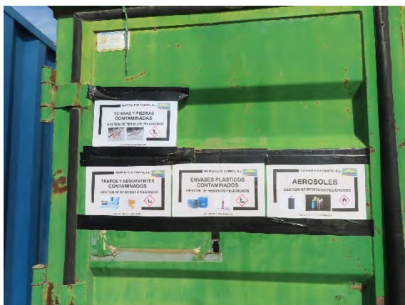
Etiquetado exterior del primer punto limpio habilitado en la obra
