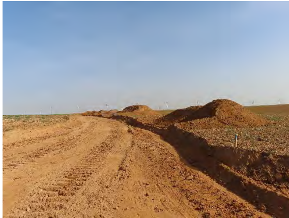
Acopios de tierra vegetal al inicio de las obras.
