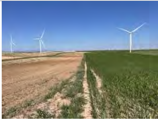
Zanja de la LAAT hacia aerogeneradores
