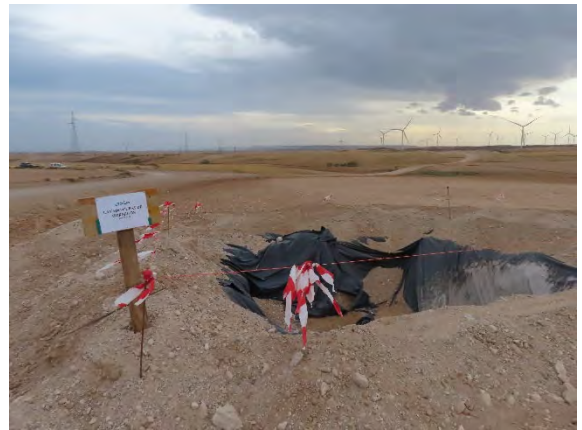
Nuevo pozo de lavado habilitado junto a la obra de la SET.
