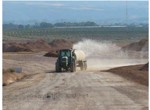
Cuba regando las superficies transitadas de las obras.
