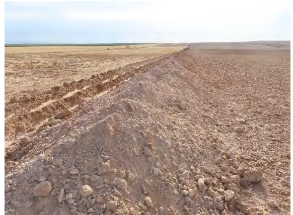
Acopios de tierra de la excavación de la zanja eléctrica, sin separación de tierra fértil.
