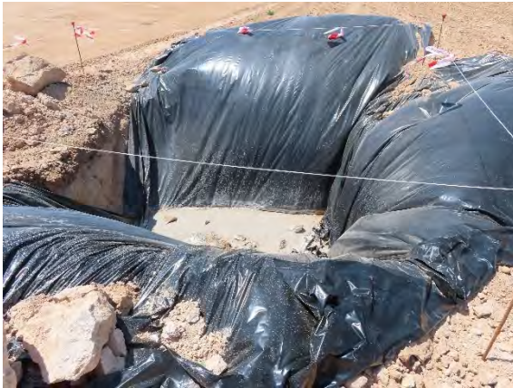
Pozo de lavado de hormigoneras en las plataformas
