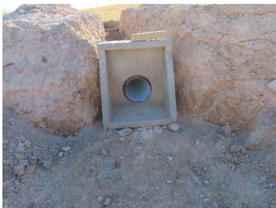
ODT en construcción.
