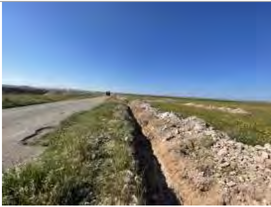
Zanja abierta para el regadío. Mismo trazado que la LAAT
