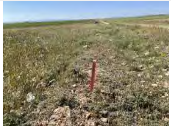
Zanja de la LAAT hacia aerogeneradores
