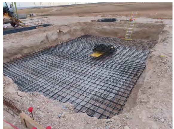
Cimentación de la SET en construcción.
