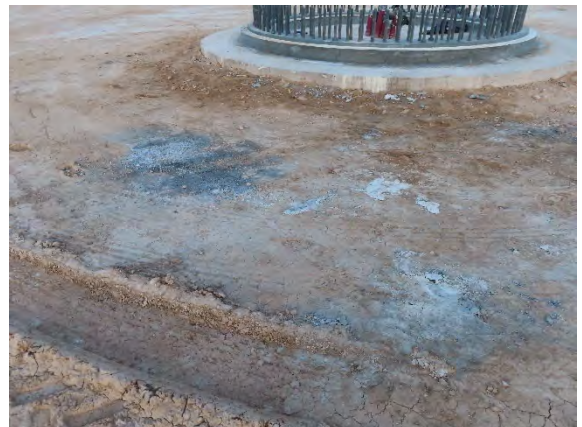
Vertido de aguas de lavado de herramientas/maquinaria impregnada de hormigón sobre el suelo en área auxiliar y plataforma del aerogenerador REII-02.
