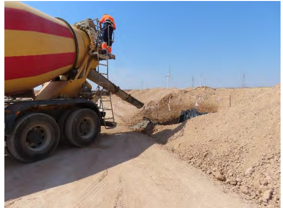
Lavado hormigonera en pozo de lavado.
