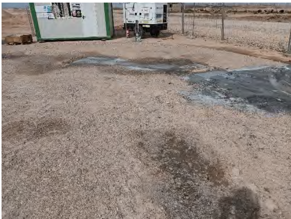
Vertido de aguas de lavado de herramientas/maquinaria impregnada de hormigón sobre el suelo en área auxiliar y plataforma del aerogenerador REII-02.
