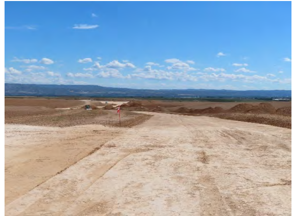
Compactación camino alineación REII-01, 02 y 03.
