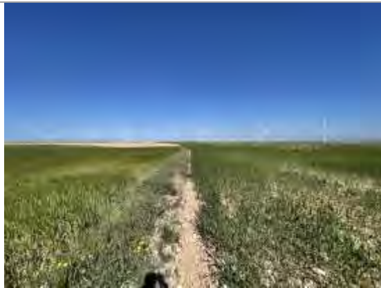
Zanja de la LAAT hacia aerogeneradores
