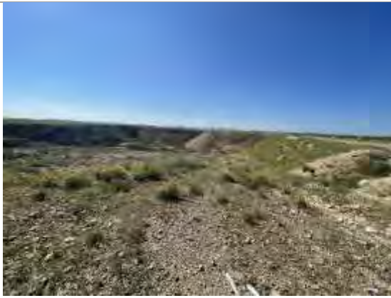
Zanja de la LAAT hacia aerogeneradores. Cantera de gravas
