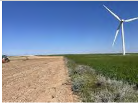
Zanja de la LAAT hacia aerogeneradores
