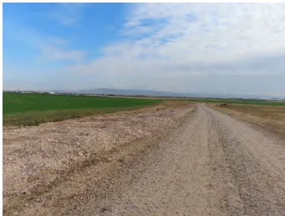
Zanja eléctrica cerrada ya, sin reposición en superficie del suelo fértil.
