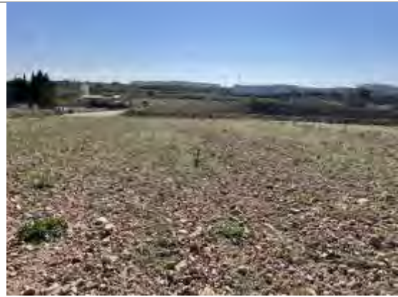
Zanja de la LAAT hacia aerogeneradores
